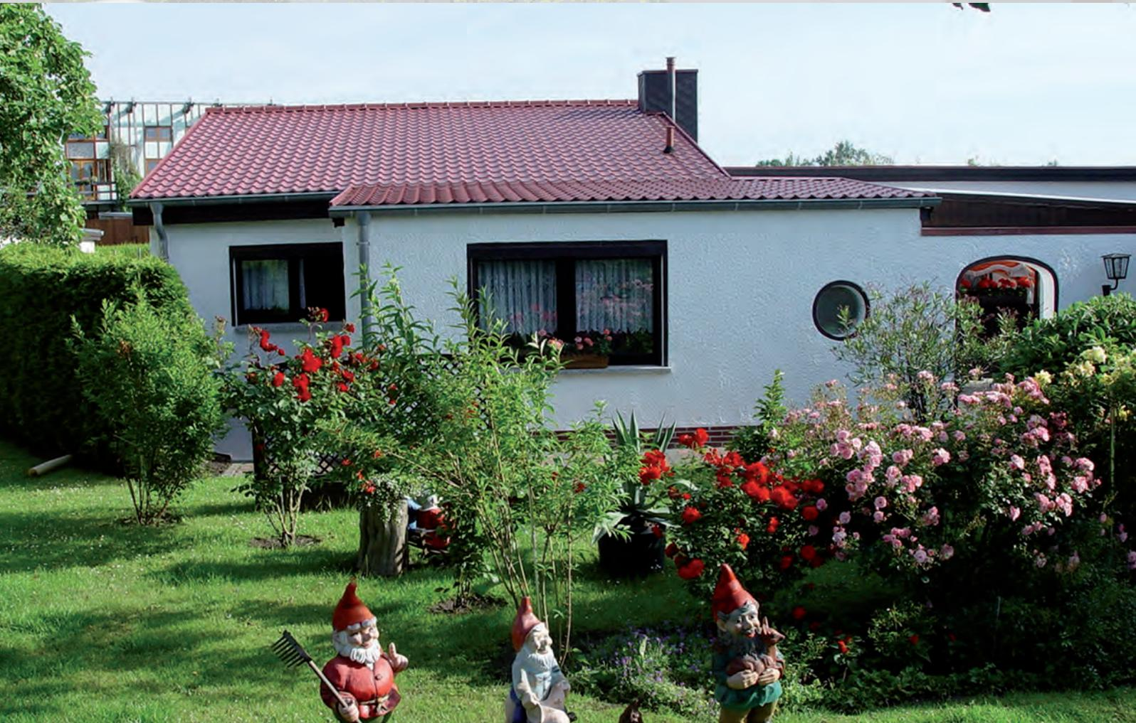
BU: Stahldachpfannen eignen sich gut zur Sanierung von leichtgeneigten Dächern. Die Stahldachpfanne LM D-Tile gefällt durch ihr klassisches Design, wodurch die Metalleindeckung wie herkömmliche Dachziegel wirkt, aber leichter und einfacher zu verarbeiten ist. Bild: tdx/Luxmetall
