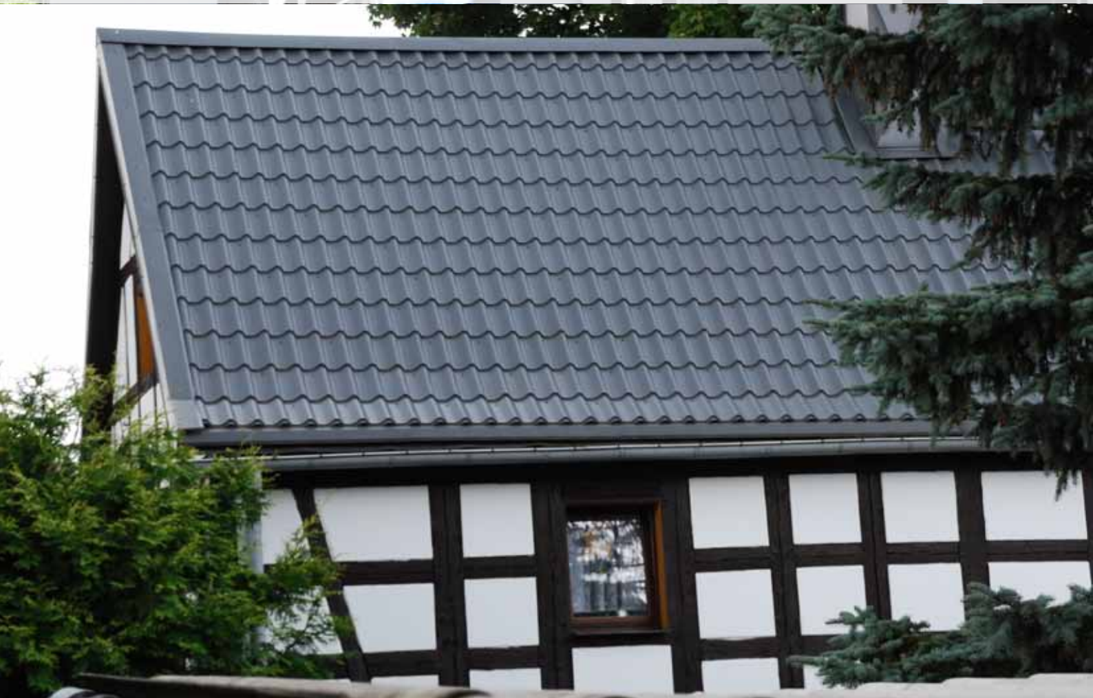
BU: Einfach und schnell lässt sich der vorhandene Dachstuhl mit Metaldachpfannen eindecken. Die Statik ist aufgrund des geringen Gewichts pro Quadratmeter nicht gefährdet. Bild: tdx/Luxmetall
