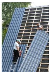
Schnelle und kostengünstige Modernisierung: Die Verlegung des Metaldachs in großen Bahnen beschleunigt den Austausch erheblich.
