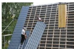
Schneller Arbeitsfortschritt: Pfannenbleche wie "LM D-Tile" sind einfach zu verarbeiten, da sie aus größeren Plattenelementen statt aus einzelnen Dachsteinen oder -ziegeln bestehen.
