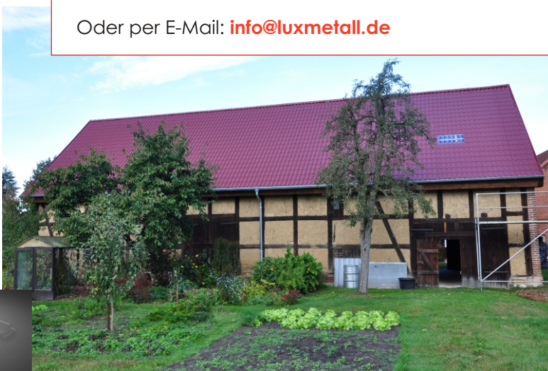
Das Dach mit der Lichtplatte
