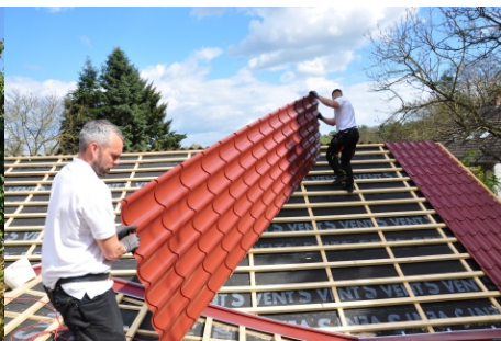
LUXMETALL -Profilbleche lassen sich sehr schnell verlegen
