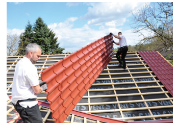
Dank schneller Lieferung ist die Sanierung in nur wenigen Wochen nach Beauftragung abgeschlossen. (Foto: epr/Luxmetall)
