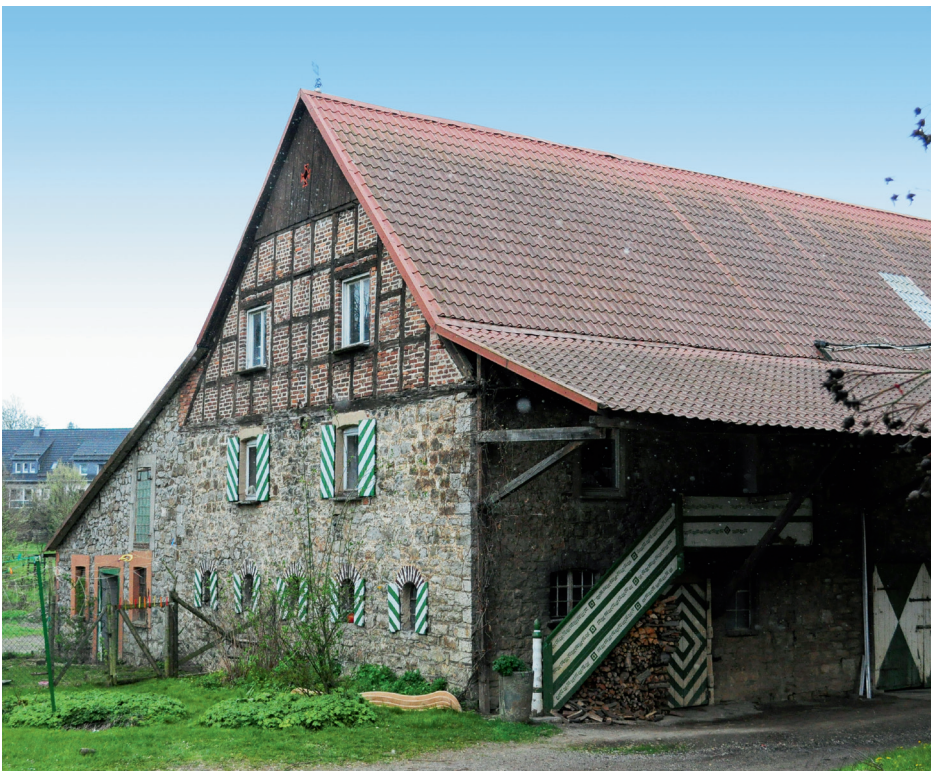
Das Kornhaus, Baujahr 1876, wurde mit Metaldachpfannen eingedeckt. Nach acht Jahren zeigt die Nordseite, begünstigt durch die spezielle Mattbeschichtung, auch wieder die für historische Dächer typische Pattina. (Foto: epr/Luxmetall)
