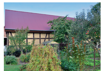
Die neue Dacheindeckung bringt das denkmalgeschützte Gebäude wieder zum Strahlen. (Foto: epr/Luxmetall)
